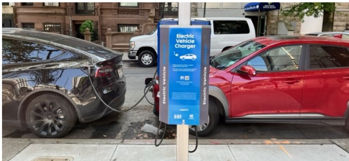
マンハッタンの縁石に設置された EV 充電ポート
